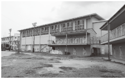
石和中学校体育館
