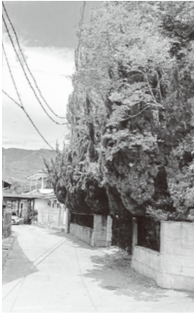
樹木が繁茂している空き家
