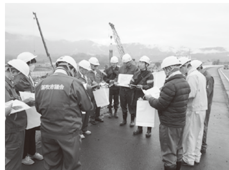
笛吹川の橋梁工事現場
