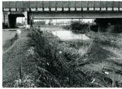
河川の底の掘削と堤防の整備の充実を
