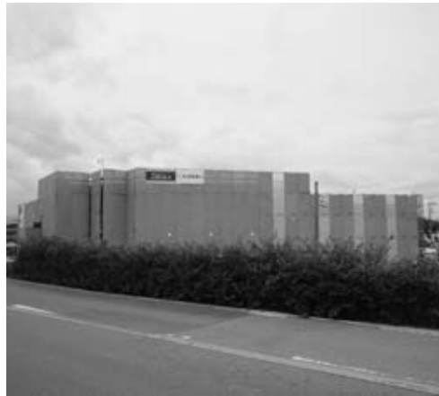
建設中の四日市場市営団地
