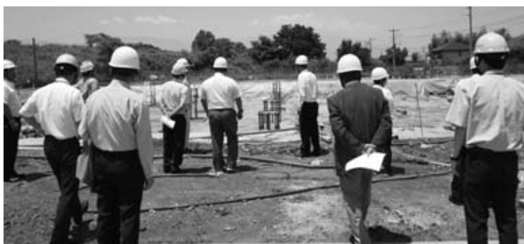
委員会審査終了後新設する給食センターの建設現場視察
