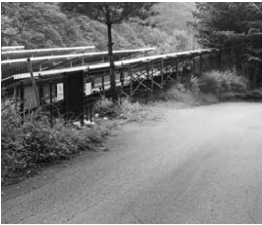
すずらん群生地に向かう道沿いに設置された太陽光発電施設
