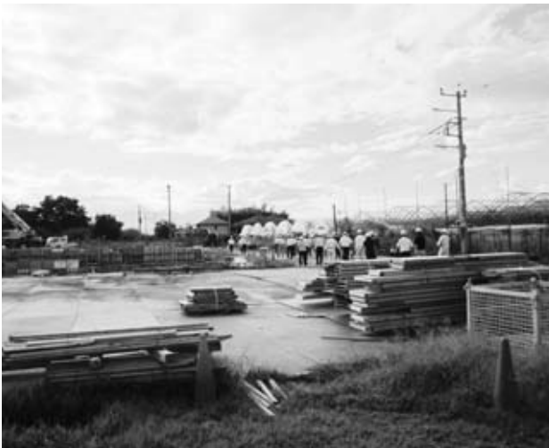
石和給食センター建設現場視察
