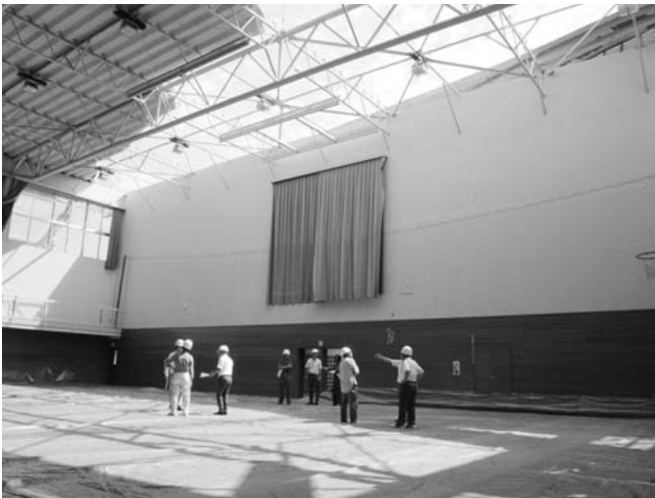
御坂中学校体育館屋根被害視察
