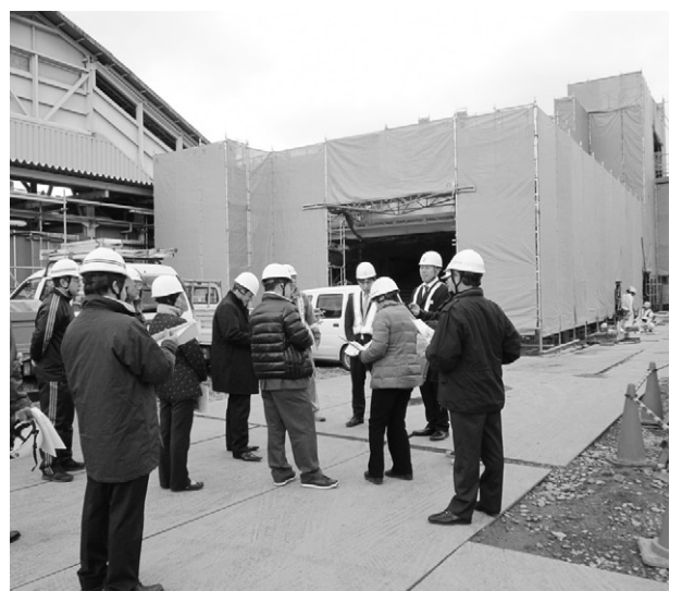
石和温泉駅舎建替工事・北口広場整備工事現場視察
