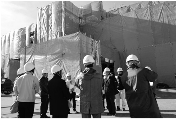
本庁舎耐震改修工事現地視察
