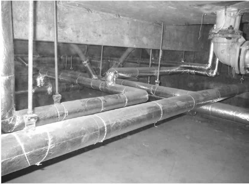
御坂給食センター給排水管施設改修工事
