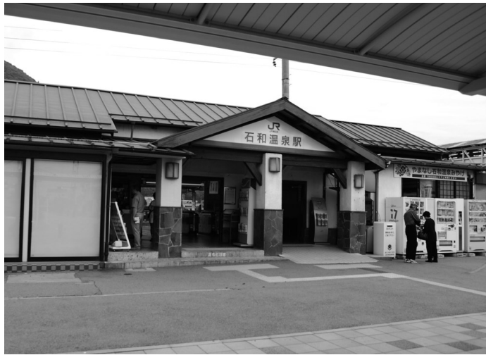
改修予定の石和温泉駅舎
