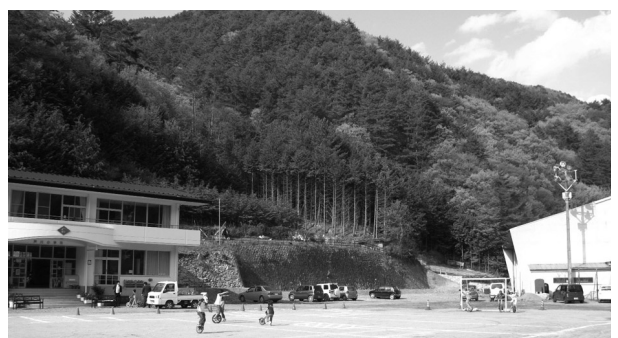
改築工事が待たれる芦川小学校屋内運動場
