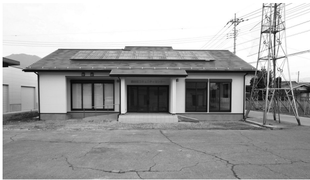
完成した春日居国府コミュニティセンター
