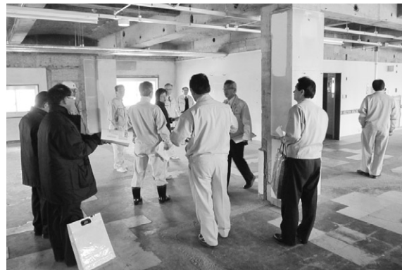
本庁南館耐震工事視察
