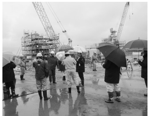
砂原橋建設工事視察
