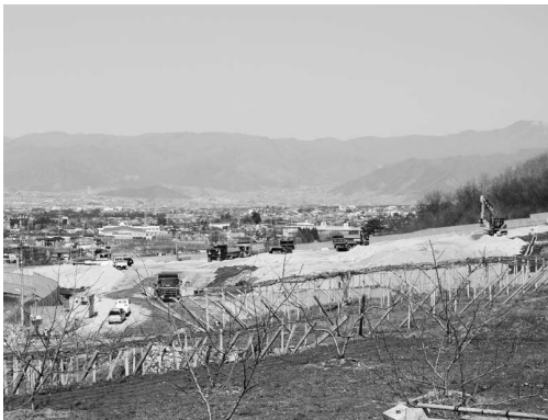
リニア実験線トンネル工事 発生土仮置場(境川地内)
