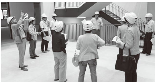
御坂中学校校舎改築工事現場視察
