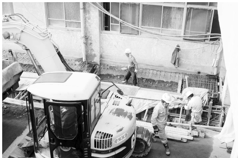
建設工事現場作業の様子
