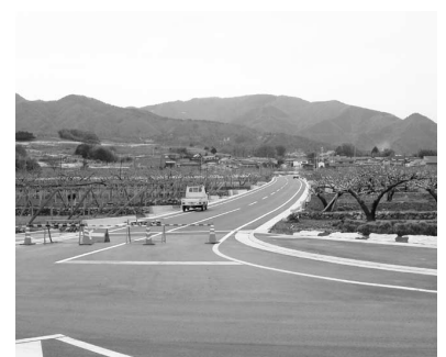
道路特定財源をもとに整備された市道境川176号線
