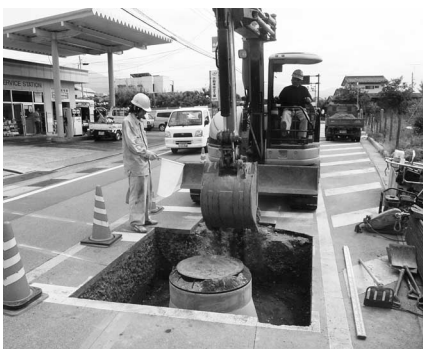
順次整備が進む下水道事業
