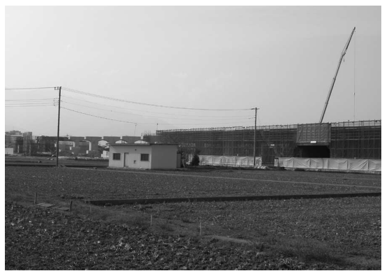
建設が進む新山梨環状道路
