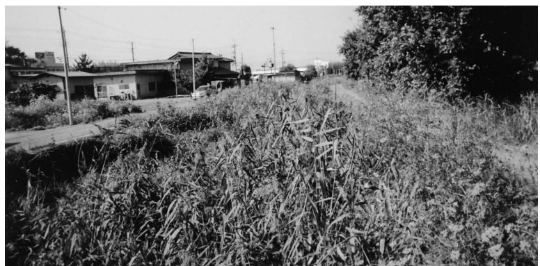
雑草が繁茂する河川(間門川)
