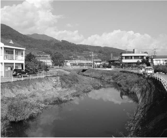
改修工事の早期着工が望まれる平等川
