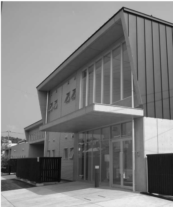
7月13日に竣工した春日居コミュニティーセンター
