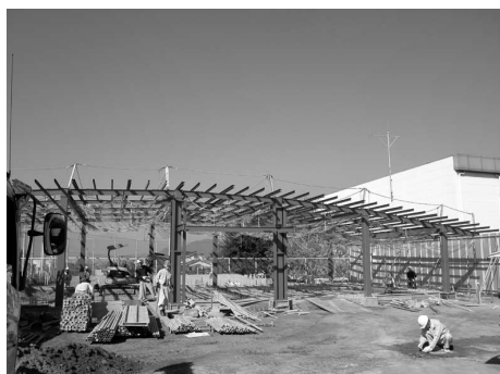
建設が進む石和東小学校地区児童館
