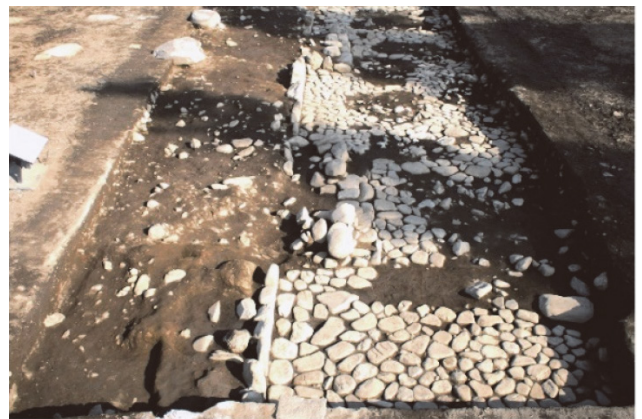
写真 講堂正面基壇・基壇化粧・階段・石敷
