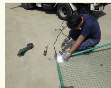
防球ネット枠溶接
