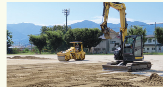
敷き均し作業
