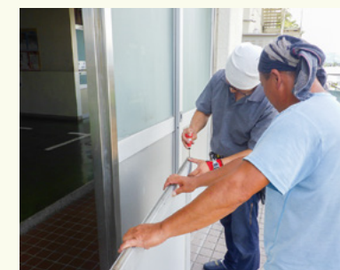
昇降口ドアの修繕
