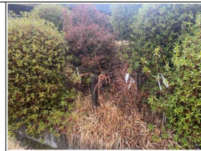
撤去工事 ④ 既存フェンス 基礎共に撤去
