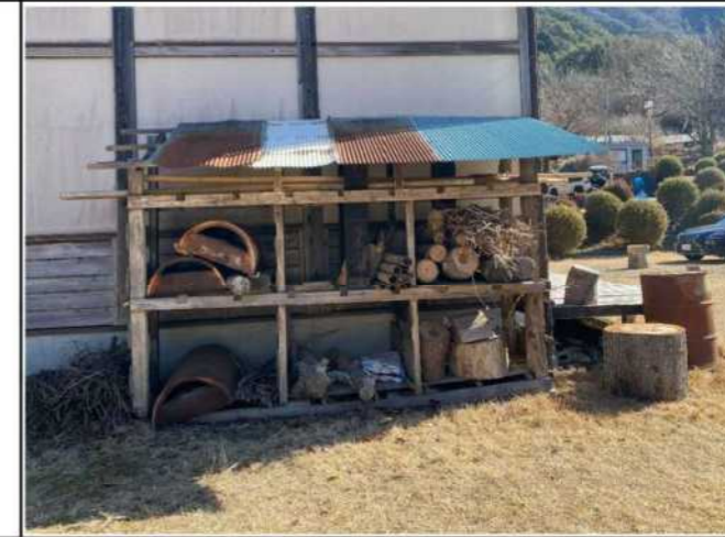
撤去工事 ② 庇撤去
