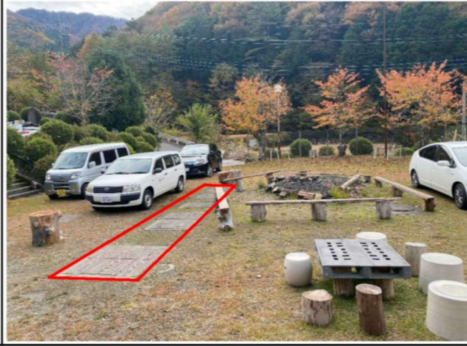
撤去工事 ⑩ 既存浄化槽
