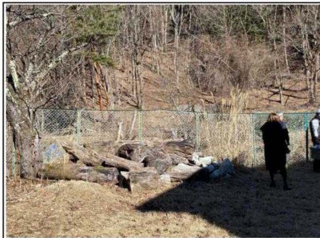
撤去工事 ⑥ 伐採木撤去
