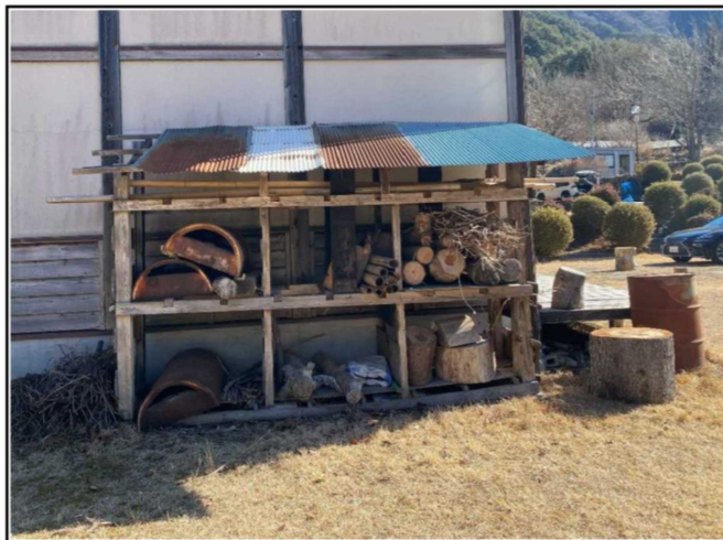
撤去工事 ③ 物置撤去
