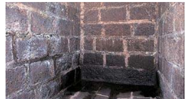
・地下ワイン発酵槽
