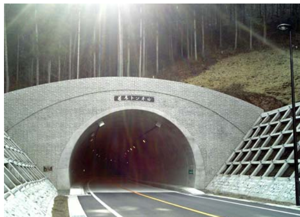
・富士北麓地域を結ぶ若彦トンネル
