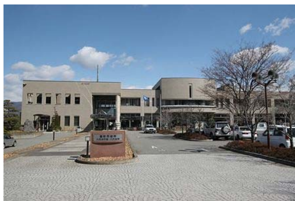
・市議会議事堂・八代支所
