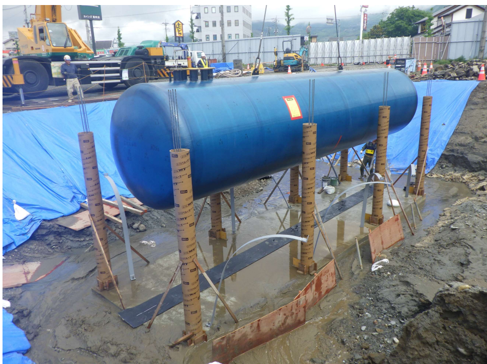
地下貯蔵タンク据え付け
