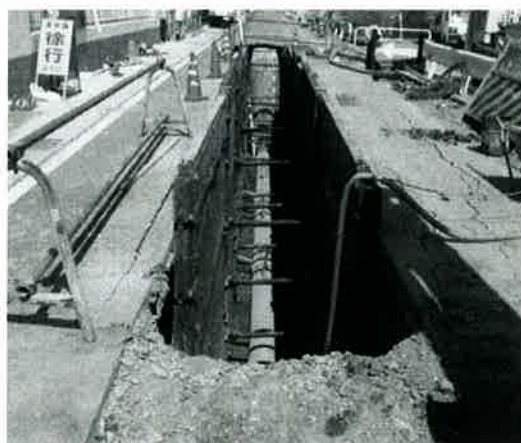
下水道工事の様子
