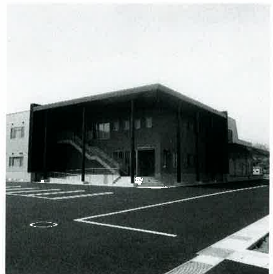
完成した石和学校給食センター
