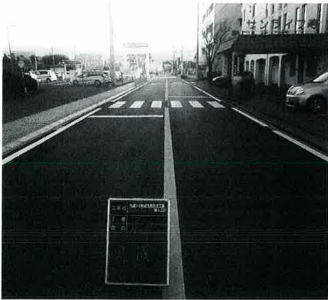
市道1-5号線修繕工事
