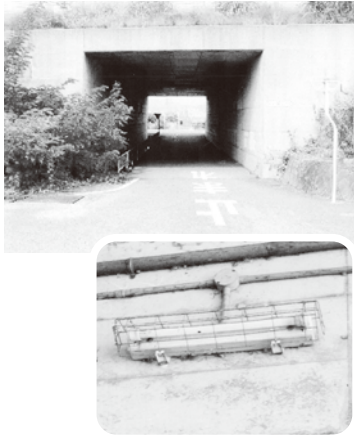
通学路にあるボックスカルバート及び防犯灯
