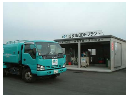
2-3 BDF精製 (ごみ収集車とBDF精製機)
