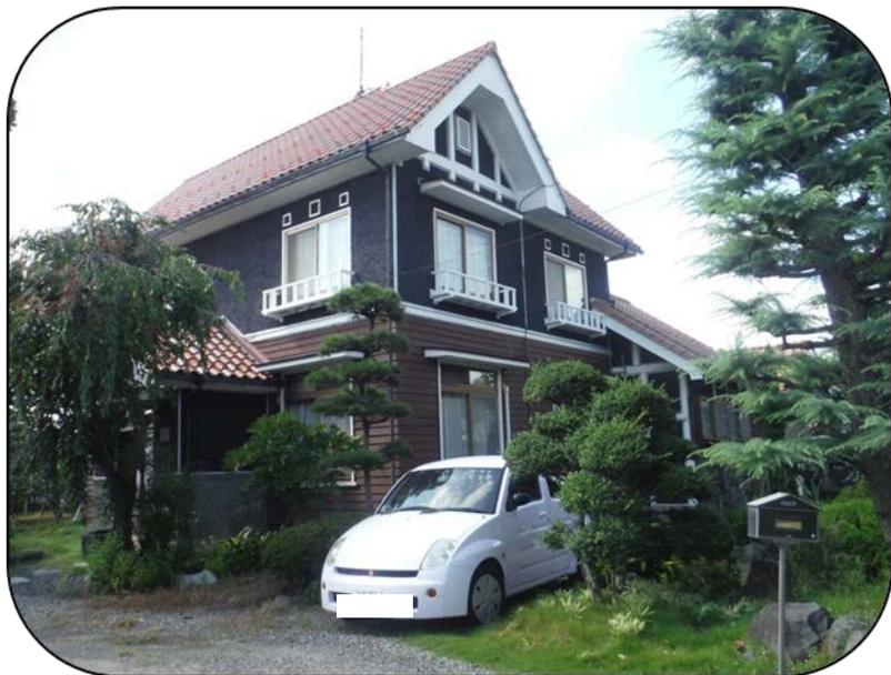
1 階を下見板貼り、2 階をドイツ壁としてハーフティンバー風の洋館で、水害を考慮して基礎を地盤より 120cm 程の高さにしている点に特徴があるよ。装飾的な避雷針や室内の漆喰しりふなど、施主の洋館に対する思い入れが強く込められているね！
