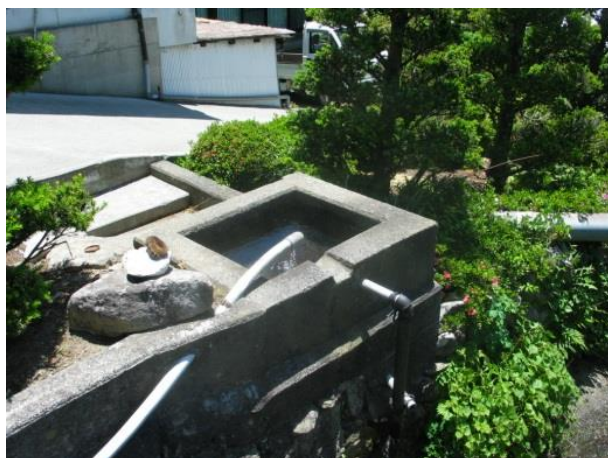
水路に設けられた溜桶
