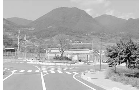
春日居町駅現状
