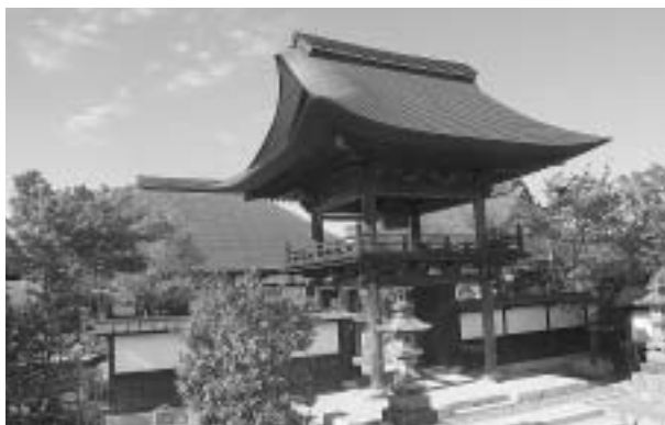
国分寺鐘楼門（手前、桁行3.3m・梁間3.0m、高さ8.8m）・本堂（左奥、桁行18.3m・梁間11.3m・高さ10.8m）・庫裏（右奥、桁行20.8m・梁間9.4m・高さ9.5m）
