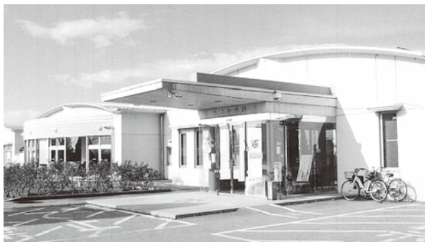
笛吹市指定避難所「みさかの湯」(御坂町成田)
