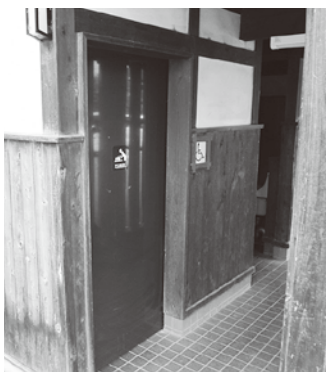
公共施設の多目的トイレ
