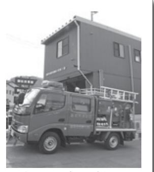
竣工した詰所と新たに導入された消防車両
