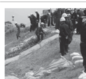
シート張り工 ブルーシートに骨組み材や重しを取り付けた状態で河川へ投入し、川側斜面を保護します。
