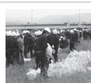
積土俵工 土のうを積んで堤防の法面などの崩落を防ぎます。
