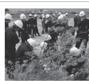
木流し工 枝葉の茂った樹木を上流側から流し入れ、樹木の抵抗により水の流れを緩やかにして、堤防の川側が崩れるのを防止します。
