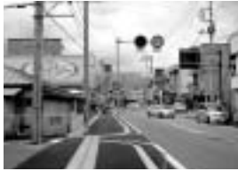
凹凸が除去され平面化された歩道
