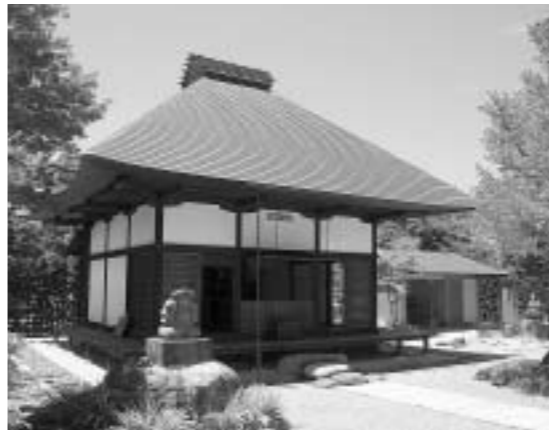
国分寺薬師堂（桁行5.7m、梁間5.4m、高さ8.0m）
