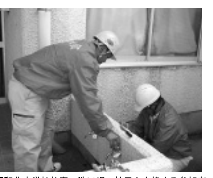
石和北小学校校庭の洗い場の蛇口を交換する参加者
