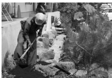
芦川小での改修作業
