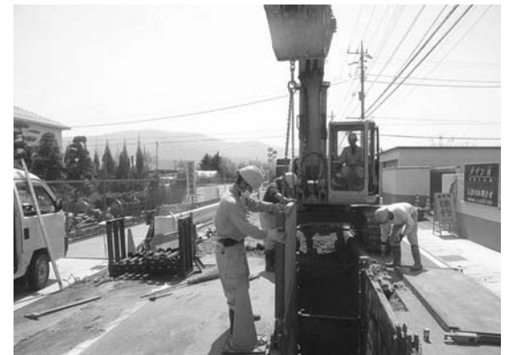
下水道の配管工事
