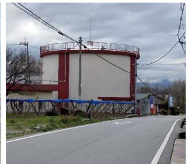
・貯水タンク
