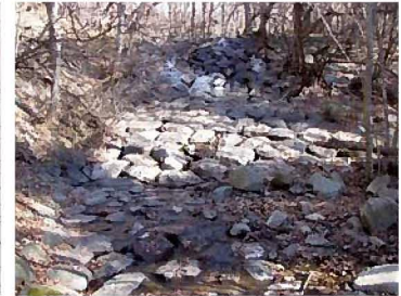
・屋敷入沢の石積みによる堰堤
