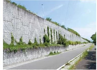
・西関東連絡道路の長大な擁壁
