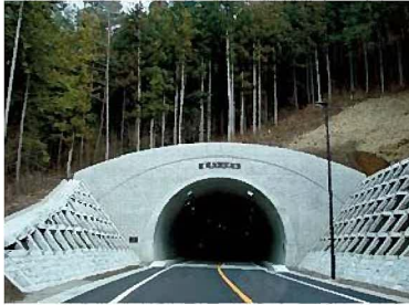
・若彦トンネルの坑口
