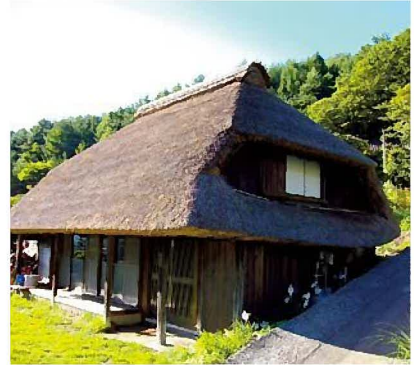
・修復された茅葺の兜造り民家
