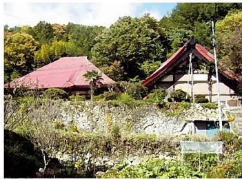
・ 石垣で造成された本国寺
