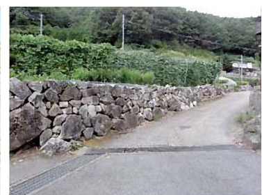
・道路沿いの石垣
