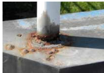
防護柵：腐食，破損
