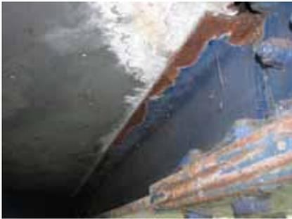
主桁：防食機能の劣化，腐食
