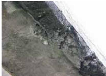
地覆：剥離・鉄筋露出
