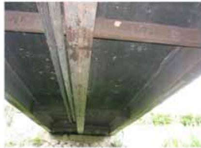
主桁：防食機能の劣化，腐食
