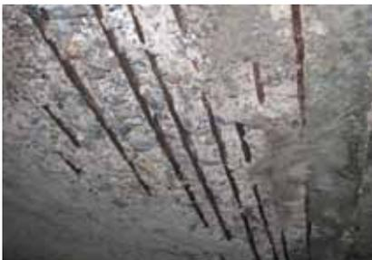
主桁（RC床版橋）：剥離・鉄筋露出
