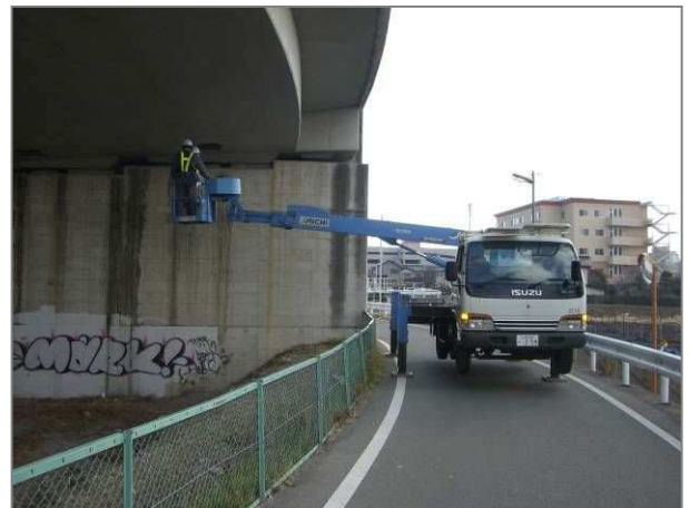
写真-3.2.2 定期点検
