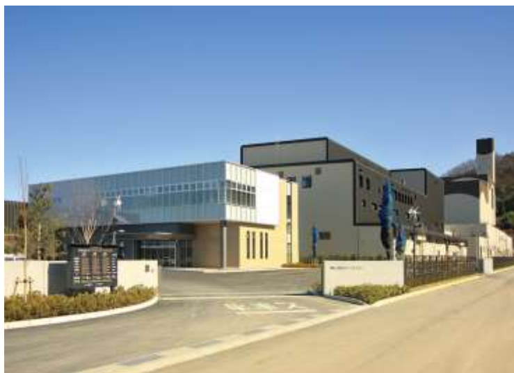
図 3-4 クリーンセンター外観
