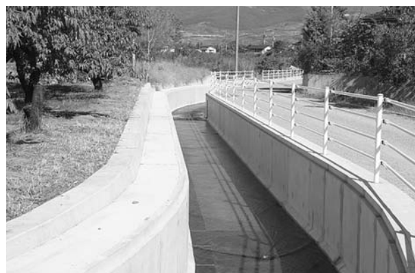
一宮町地内準用河川整備
