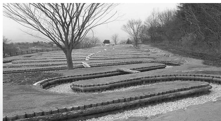
八代町地内「ほたるの里」整備
