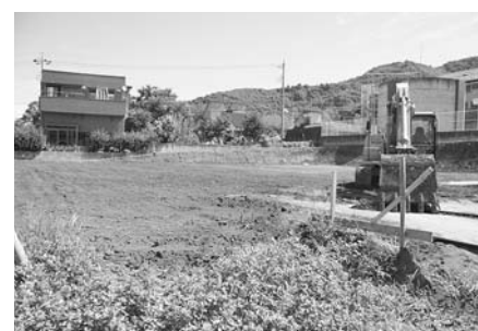
境川浄水場建設現場(平成22年度完成予定)
