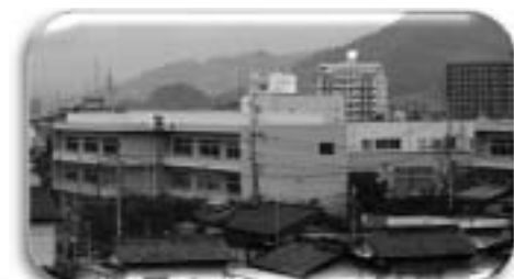
小学校校舎改修
