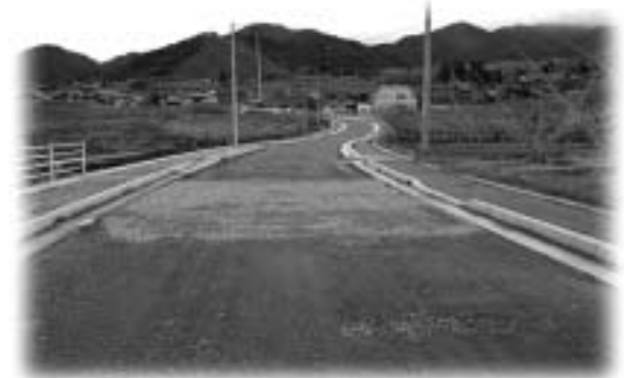
一宮地内 塩田・金沢線道路整備
