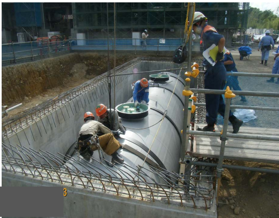
地下タンク貯蔵所 タンク据付検査状況
